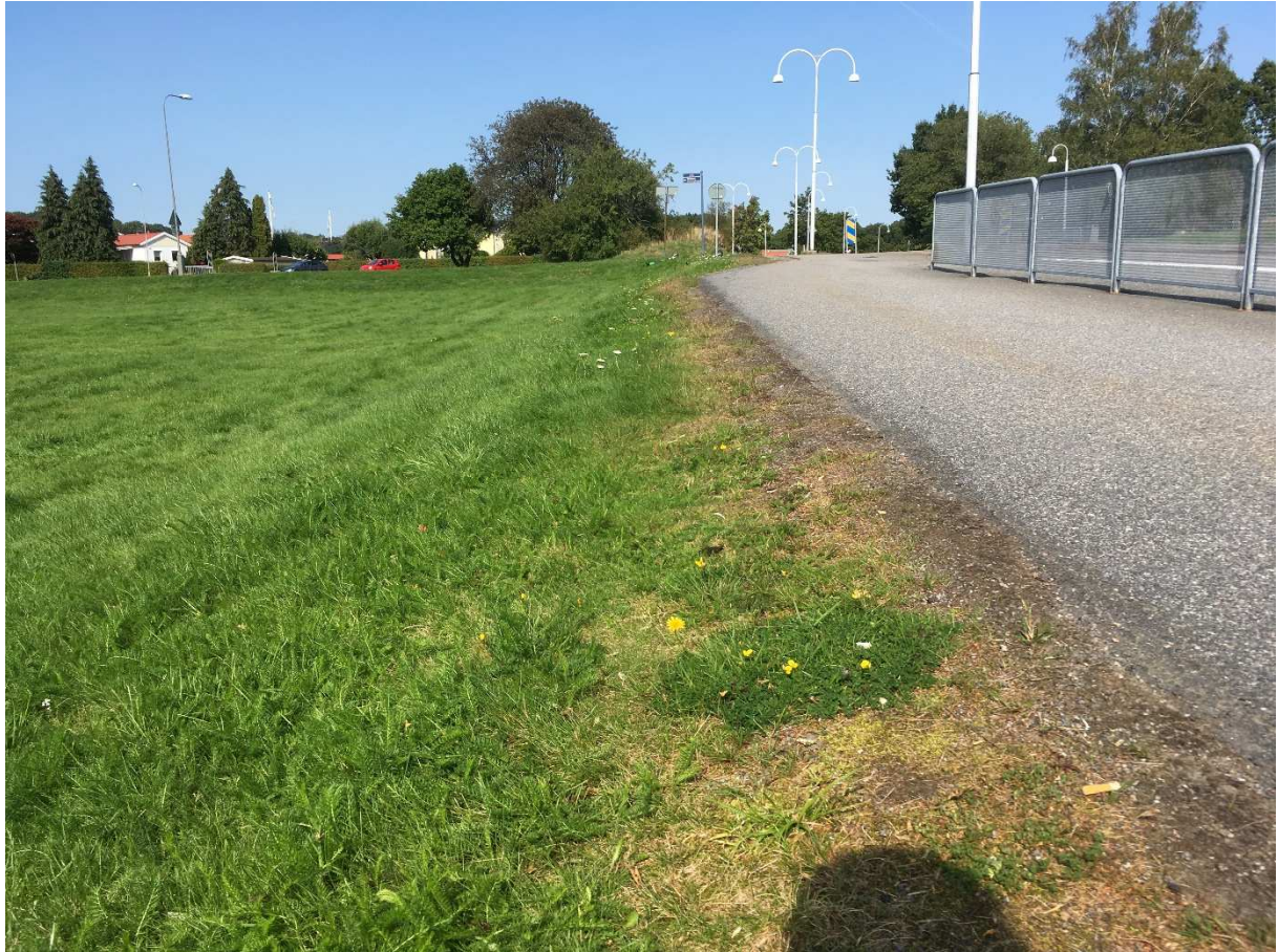
Figur 7. Utredningsområdet sett från Köpenhamngatan och norrut. Utredningsområdet till vänster samt gång- och cykelbana längs med Dysiksgatan till höger. Kantsten saknas längs med GC-bana.
