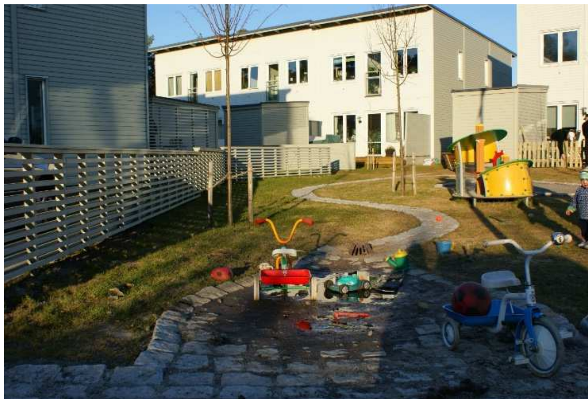
Figur 21. Öppet avvattningsstråk i låglinje (Sweco).
